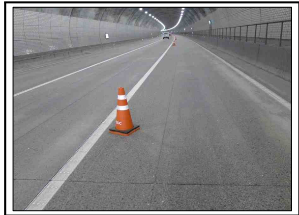
사진번호 8 포장부 전경 외관망도 -
