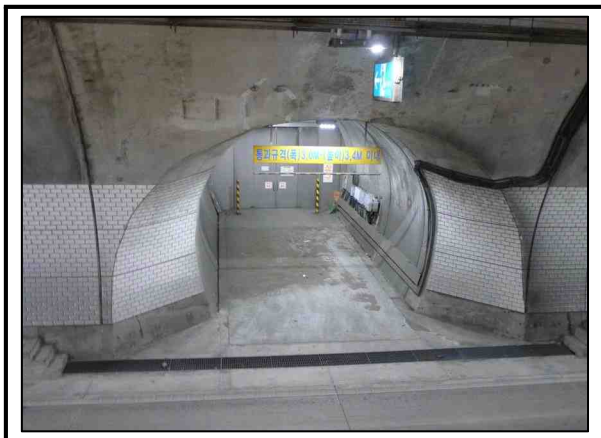
사진번호 79 피난연락갱(차량용) 외관망도 - 전경(Span 56)
