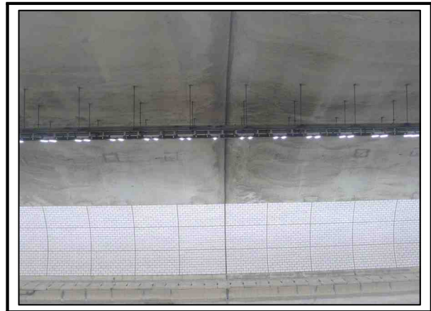
사진번호 20 측벽부 타일 시공현황 외관망도 -
