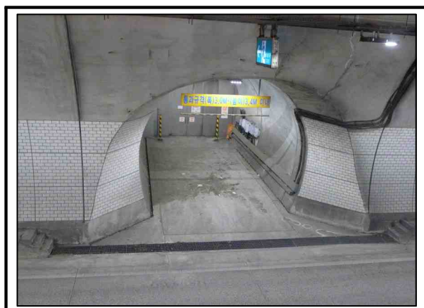
사진번호 82 피난연락갱 S130(차도용) 외관망도 - 상태양호
