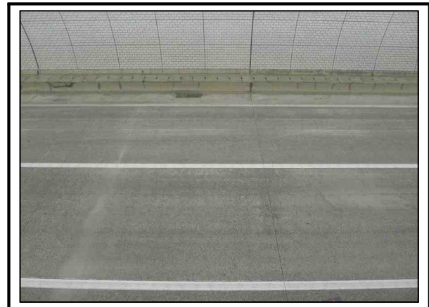
사진번호 70 콘크리트 포장 현황 외관망도 -
