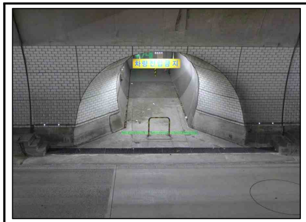
사진번호 80 피난연락갱(인도용) 외관망도 - 전경(Span 93)
