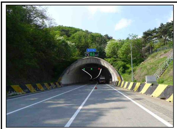
사진번호 47 종점부 갭문 외관망도 - (벨마우스식) 전경
