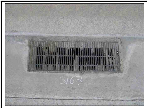
사진번호 7 배수시설 전경 외관망도 -
