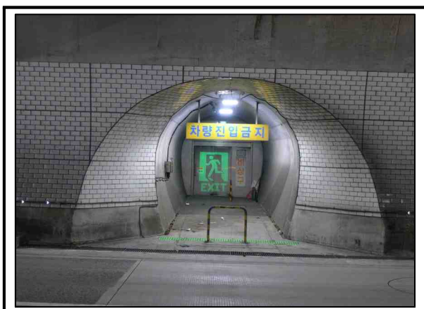
사진번호 81 피난연락갱 S93(인도용) 외관망도 - 상태양호
